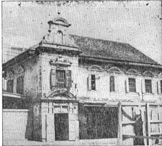
อาคารพาณิชย์ถนนบ้านหม้อ เคยเป็นที่ทำการธนาคารแห่งแรกของเมืองไทย เมื่อแรกตั้งเรียกว่า “บุคคัลลีย์” หรือ BOOK CLUB จะถูกรื้อลงวันใดวันหนึ่งก็ไม่รู้ได้
