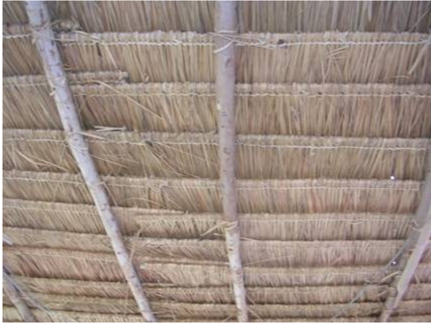
ภาพที่ 6 การมุงหลังคาด้วยไผ่หญ้า
