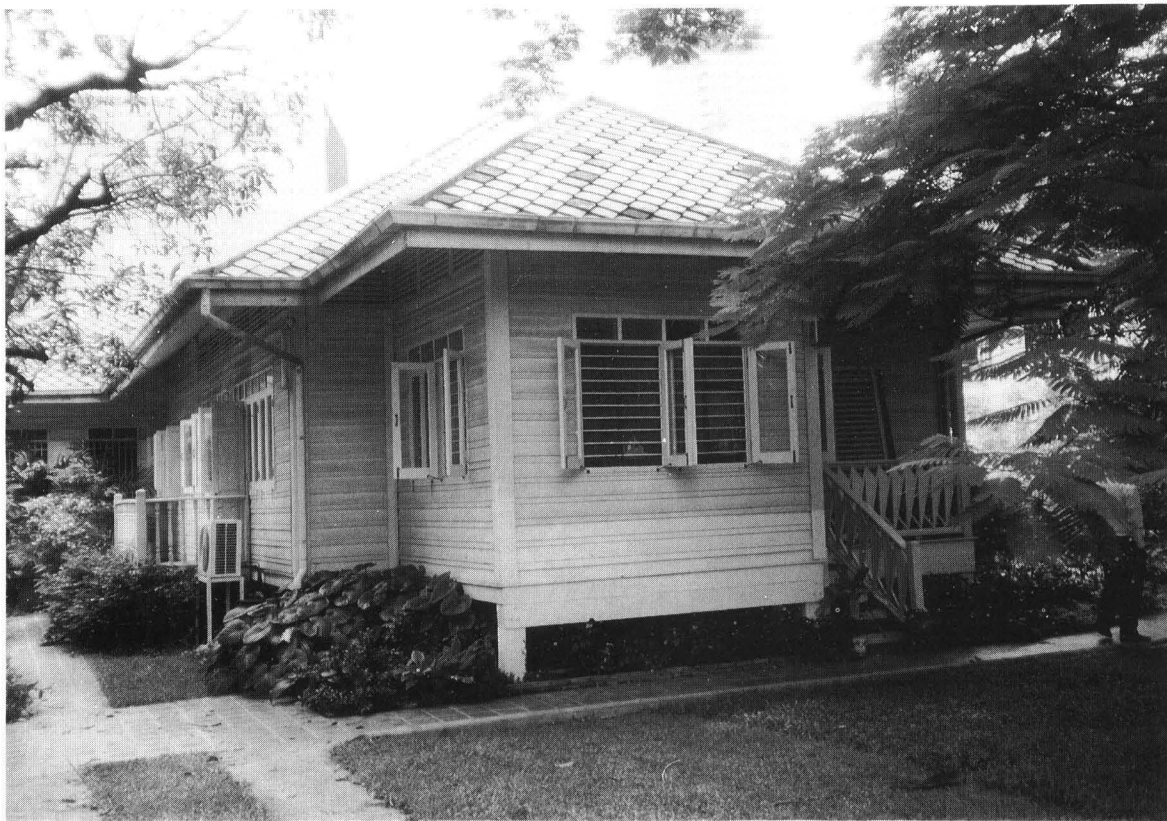
มุมหนึ่งของบ้านซอยอารี กรุงเทพฯ
